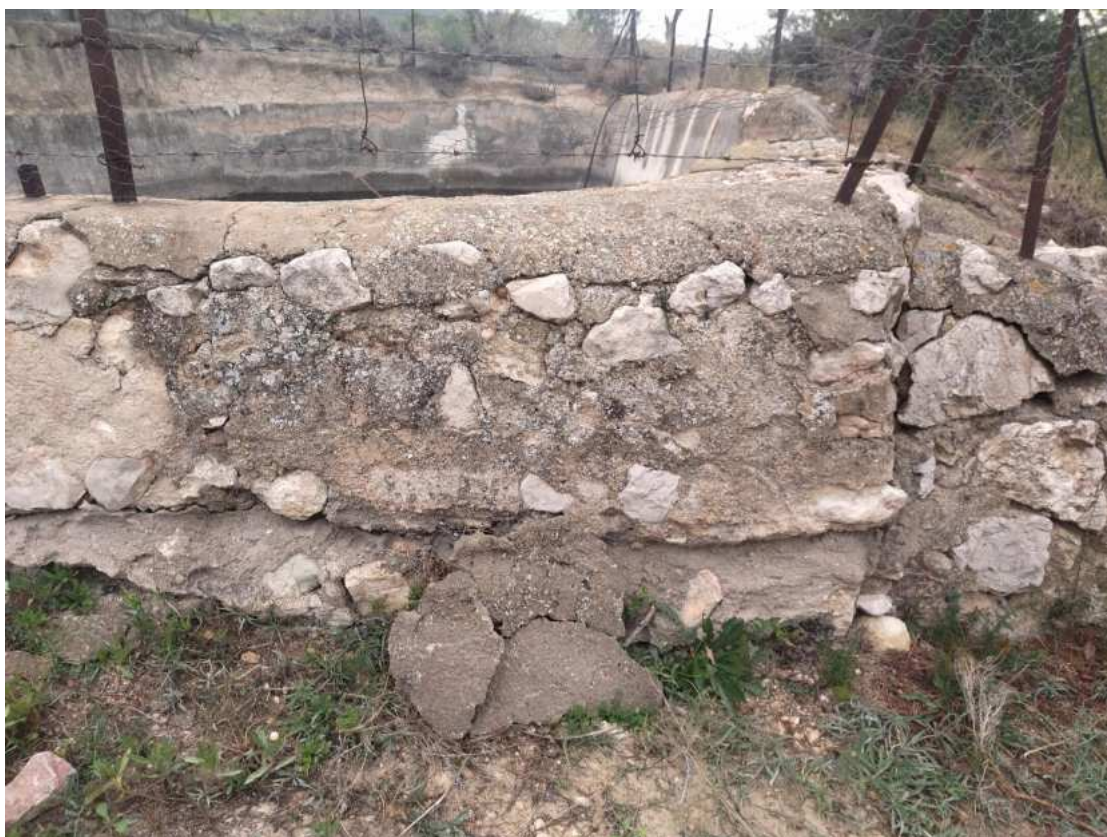
Detalle de la fábrica del muro perimetral de la balsa
