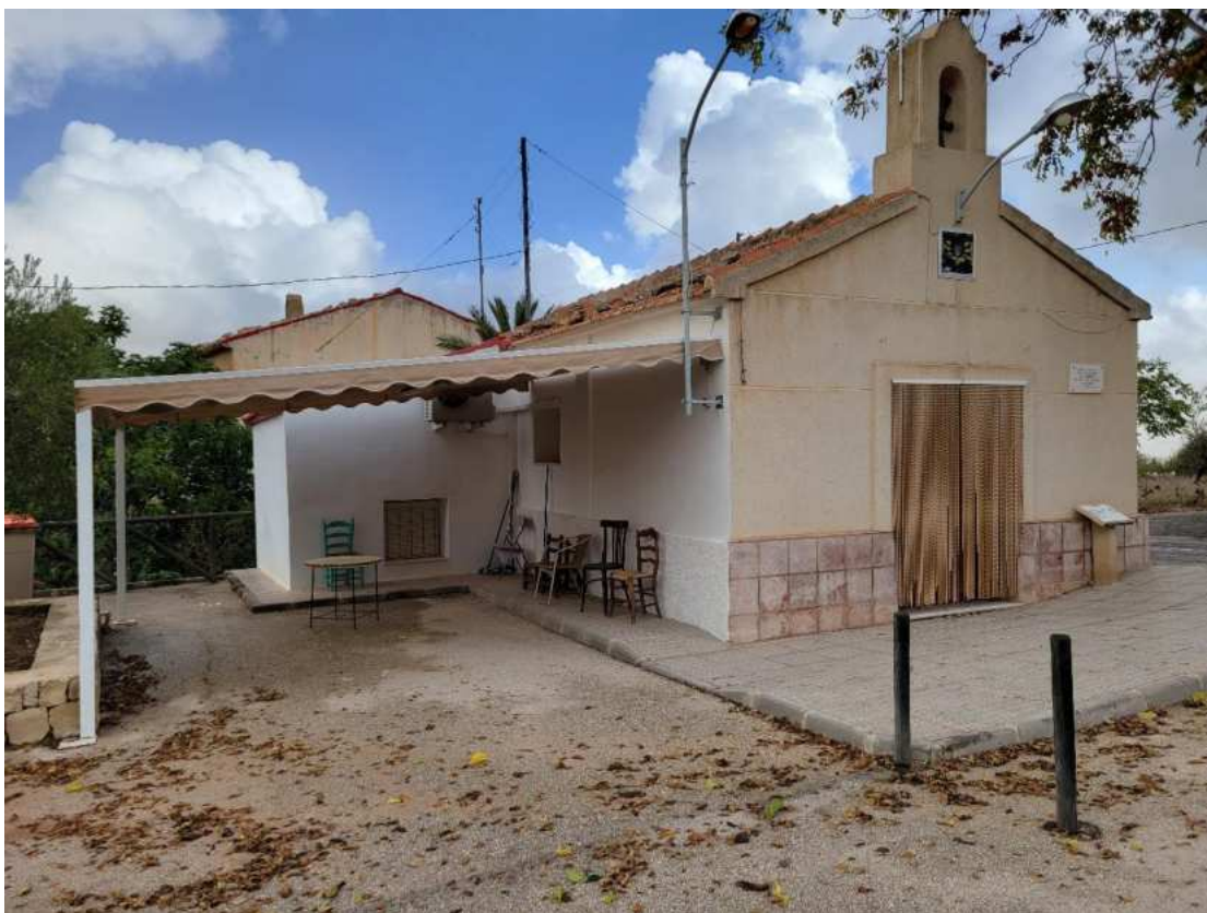
Vista de la fachada principal
