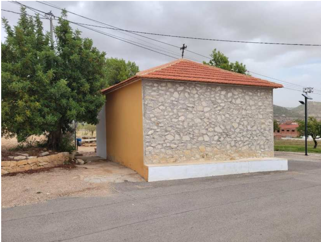
Vista del exterior desde el suroeste
