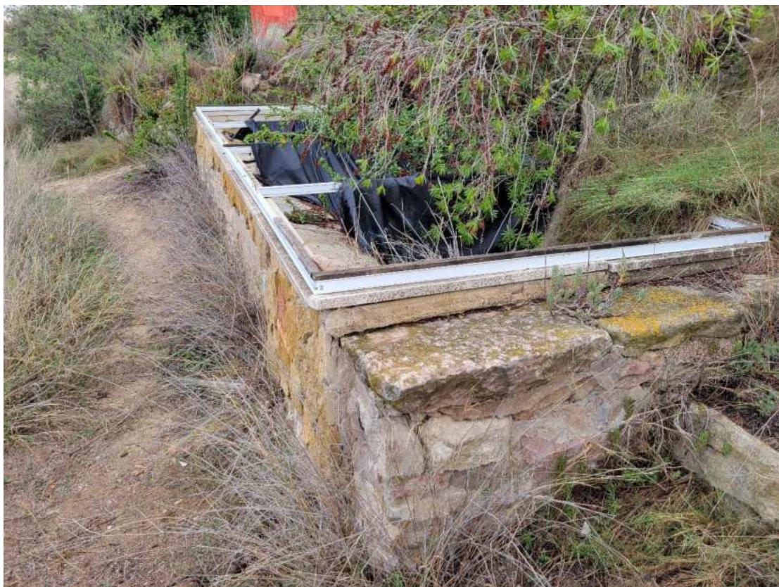
Vista general del lavadero
