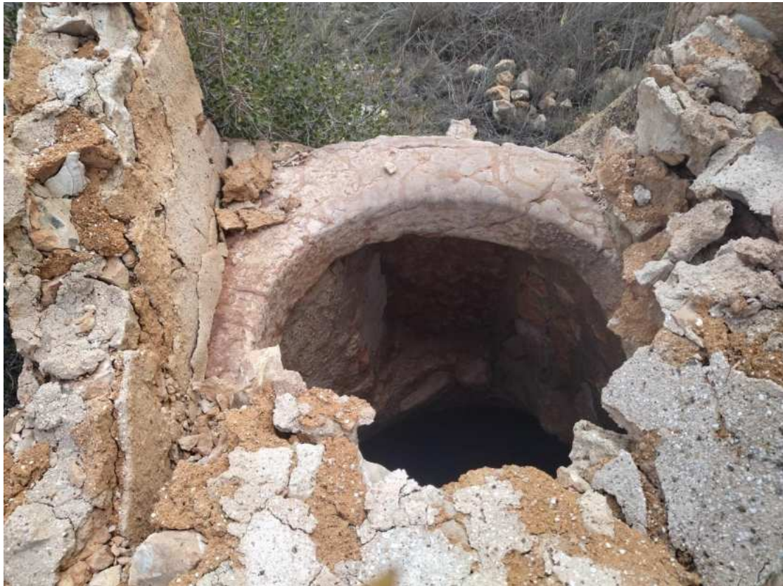
Detalle de pieza de mármol rojo alicante en la fábrica del brocal sur
