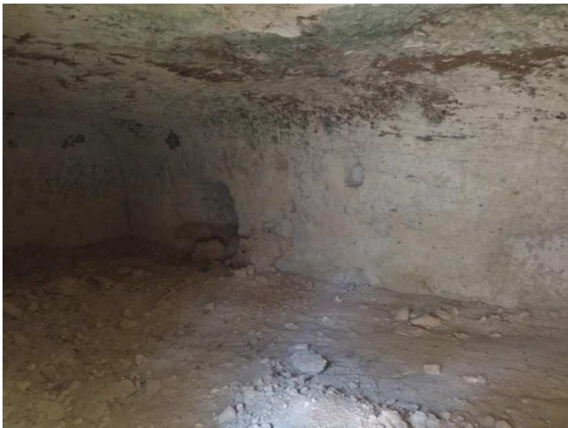
Cavidad excavada en uno de los laterales del minado
