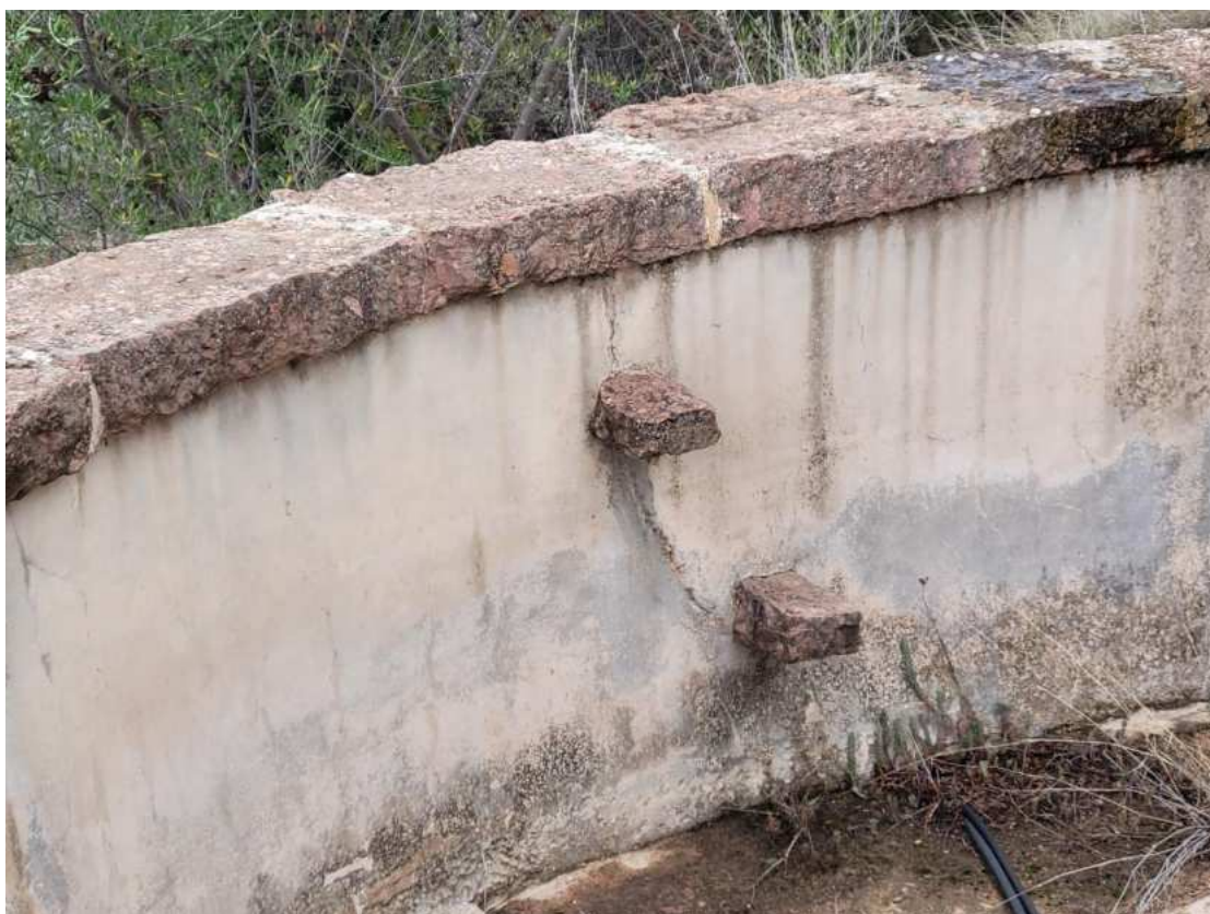
Detalle de los escalones de acceso a la balsa
