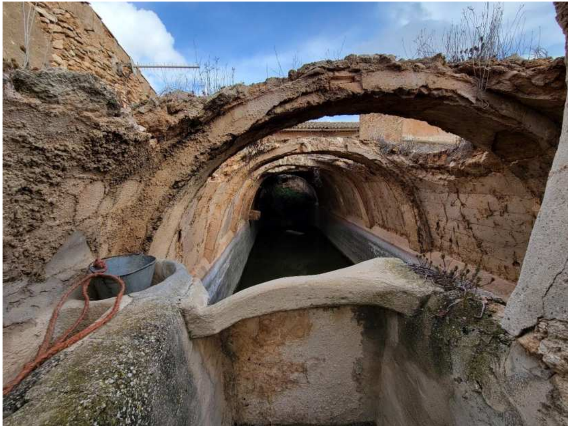
Interior del depósito
