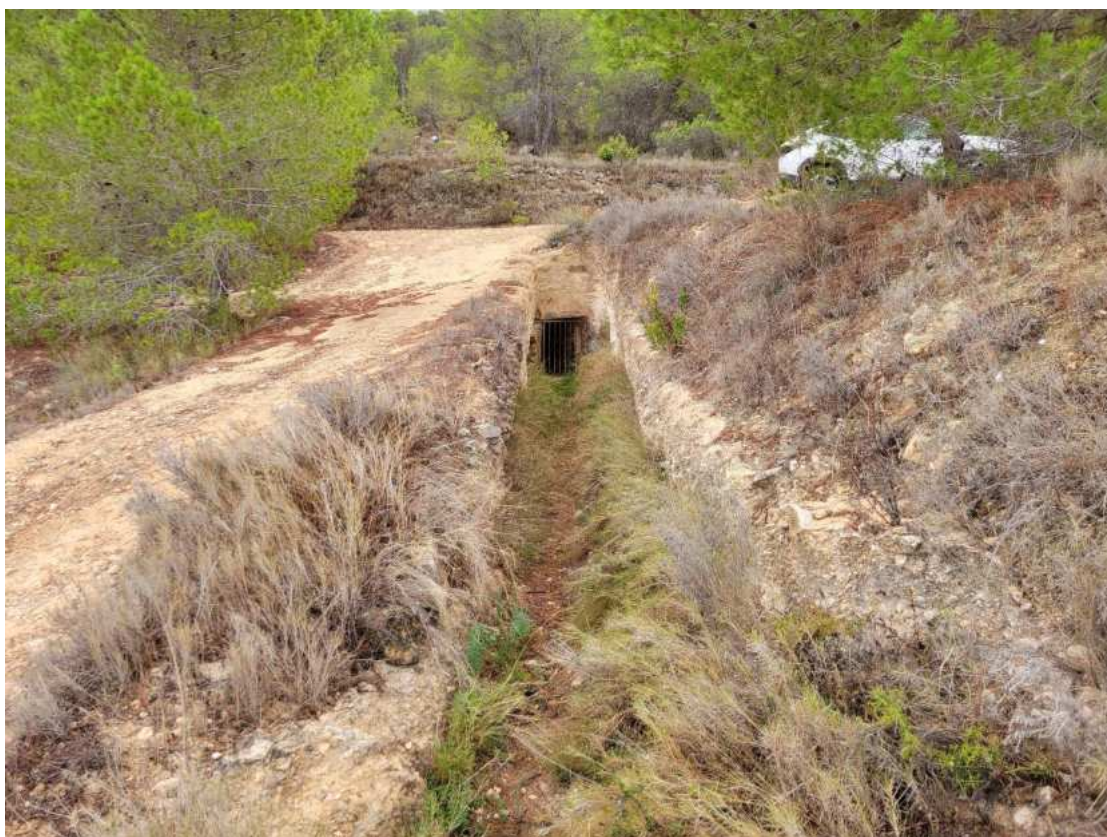
Vista del minado desde el norte
