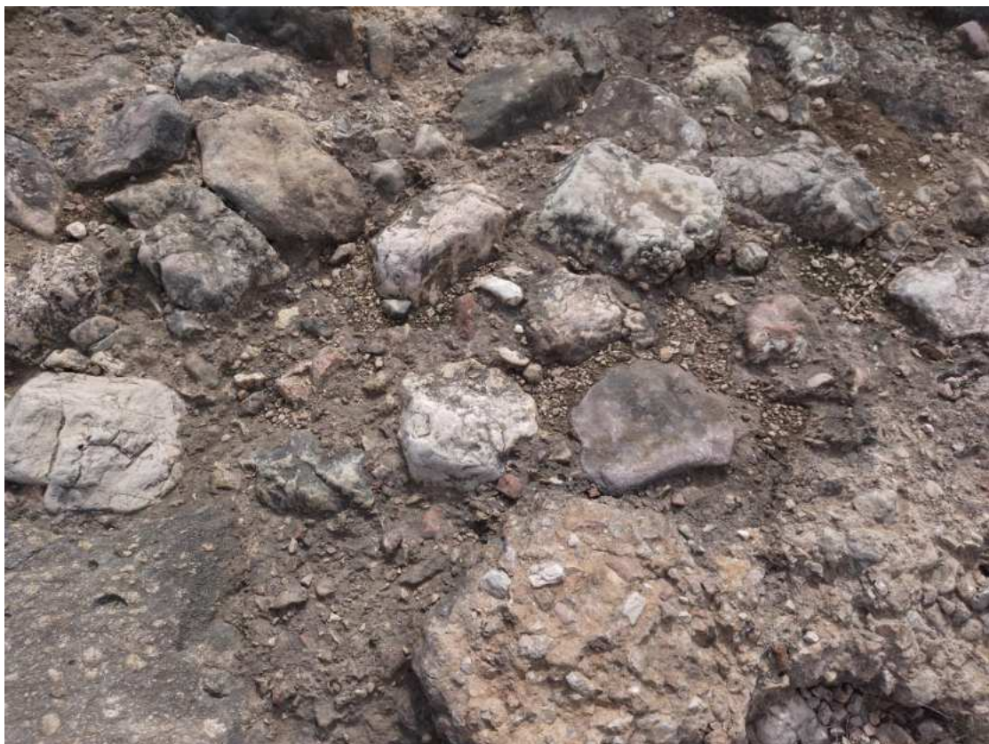
Detalle de la fábrica
