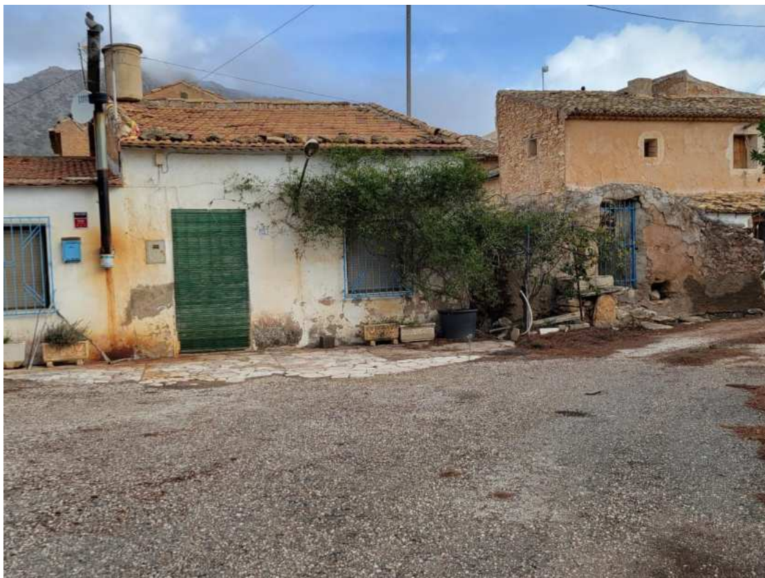
Vista del aljibe junto al inmueble anexo
