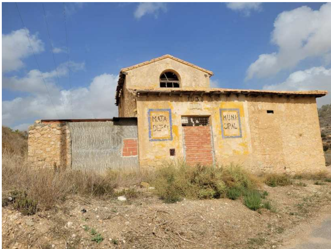
Vista de la fachada principal
