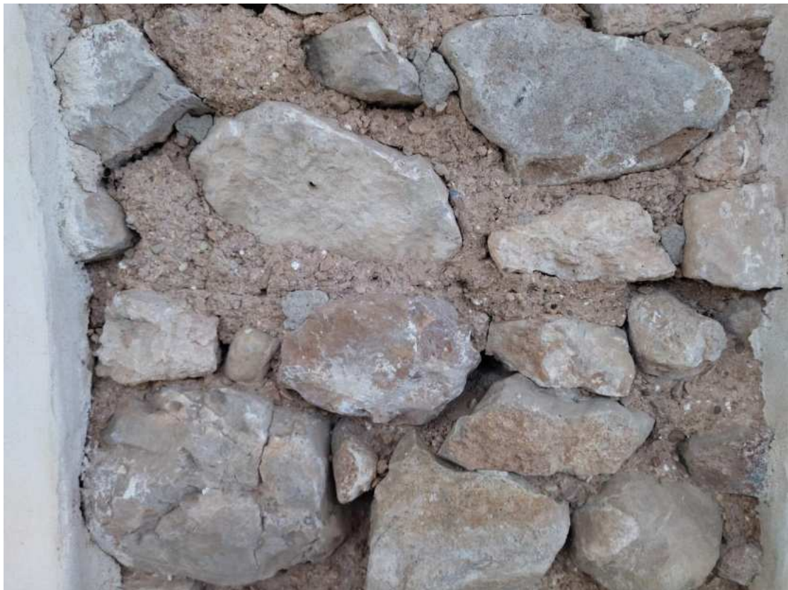
Detalle de la fábrica
