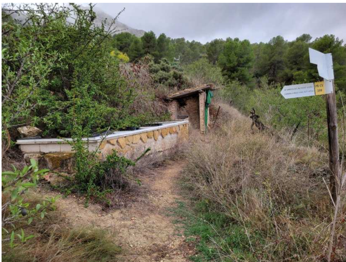
Conjunto de lavadero y fuente
