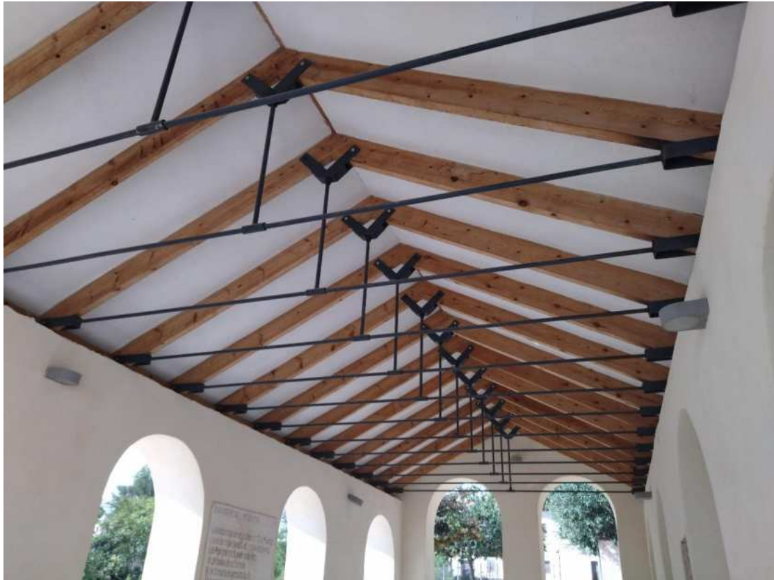
Detalle de la cubierta
