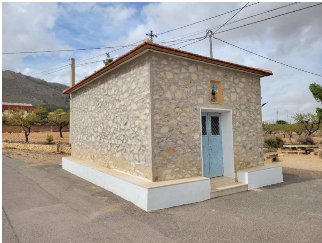
Vista del exterior desde el sureste
