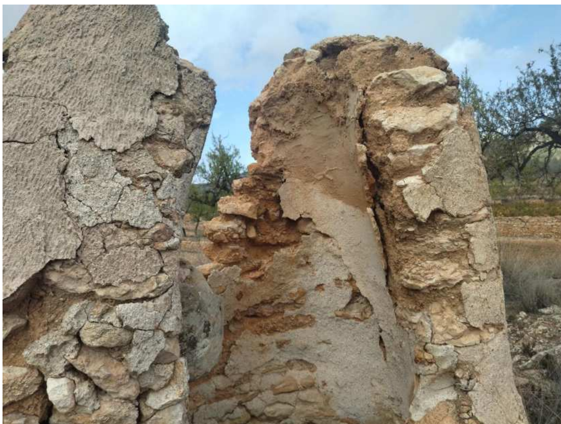
Detalle de la fábrica del brocal norte
